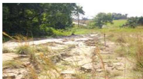
Photo 5: Erosion du sol dans la zone du projet.
