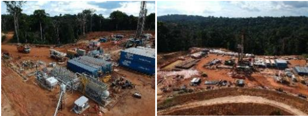
Photo 4: Exemple de réalisation (Cluster / Diga5).
