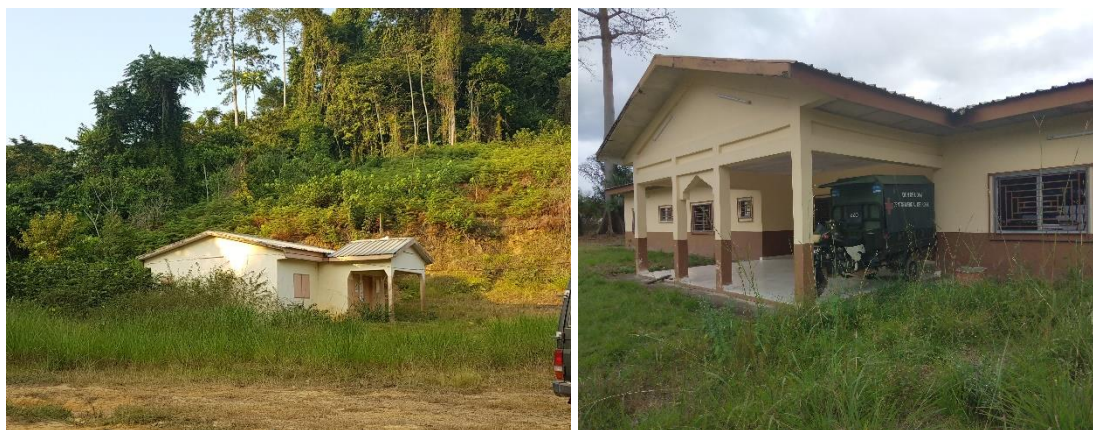
Photo 17 : Dispensaire de Divindé, à l'abandon. A droite, le dispensaire d'Ikobey
