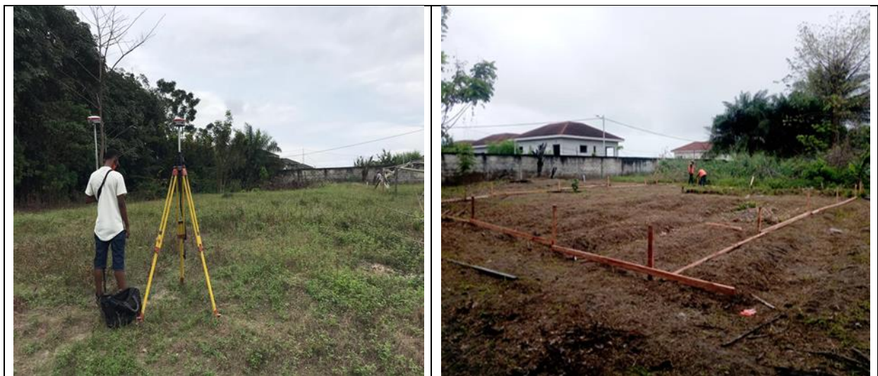
Figure 8 : Vue du site de construction des deux laboratoires
